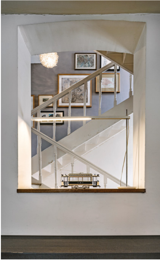
Diese Öffnung sitzt in der ursprünglichen Außenwand des nachträglich verlängerten Gebäudes.
