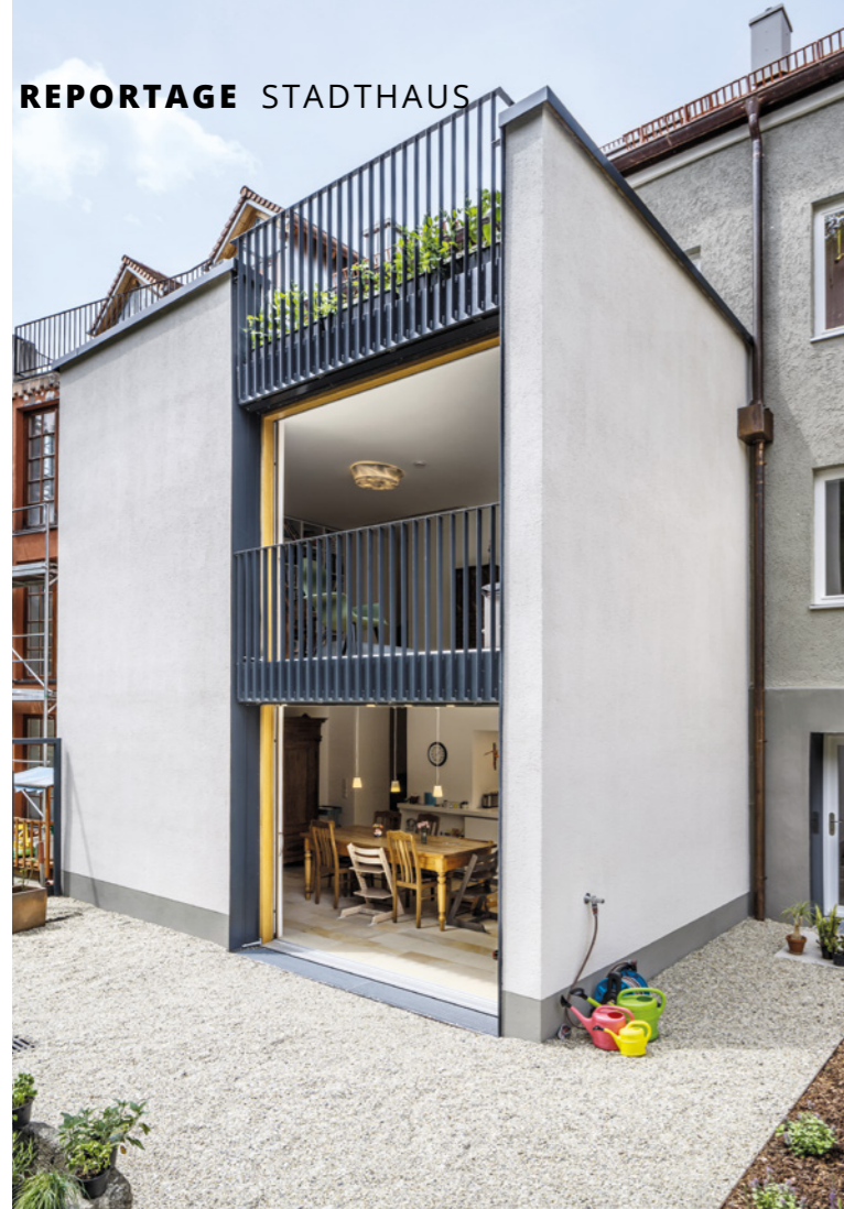
Der zweigeschossige Anbau optimiert das Raumprogramm für die fünfköpfige Familie. Vom Esszimmer aus erschließt eine große Schiebetür den Garten.
