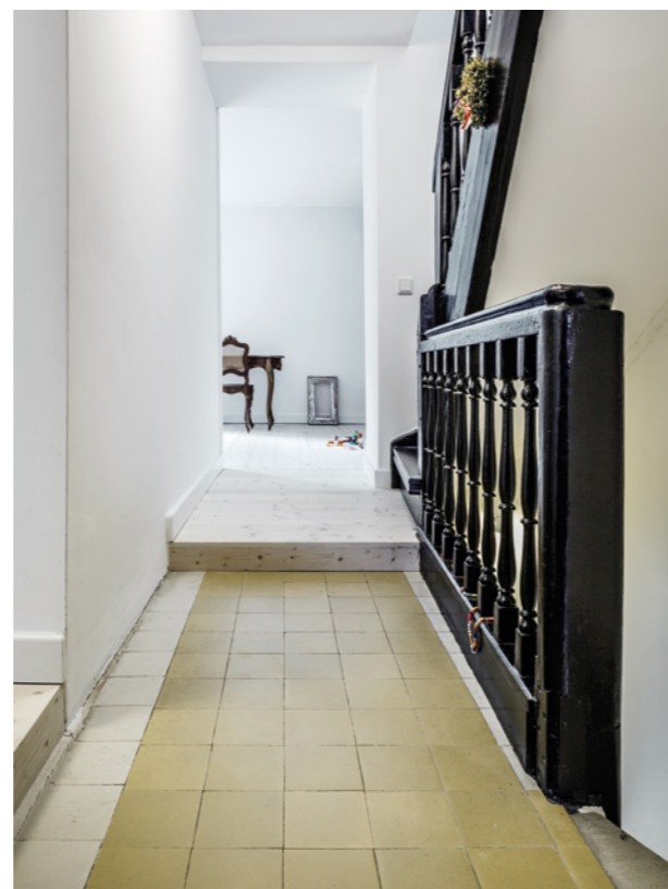
Die alte Treppenanlage und die Bodenbeläge im Eingangsbereich konnten saniert und erhalten werden.
